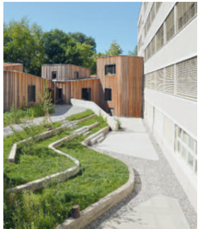
Der Werkhof: Sitzmauern aus Stampfbeton zeichnen mehrere Ebenen in Hang und machen diesen für Aufenthalt, Spiel oder als Bühne für Aufführungen im Hofbereich nutzbar.
